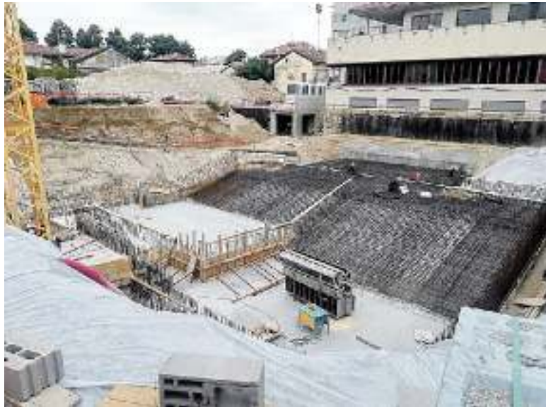
INTERVENTO Il cantiere in via Asquini
