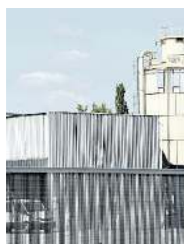
TERMOVALORIZZATORE L'impianto di Manzano
